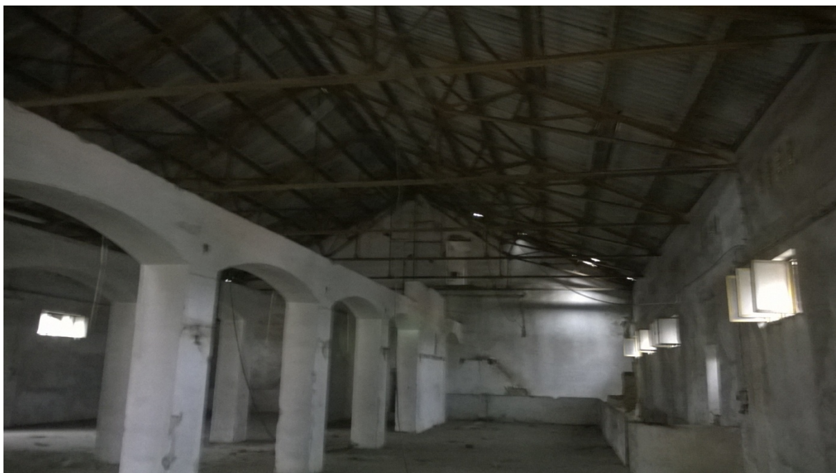
ÉNy-i padozatos raktár padlástér acél rácsostartós fedélszék
