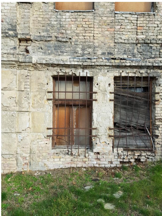
DNy-i homlokzat befalazott ablakok részlet
