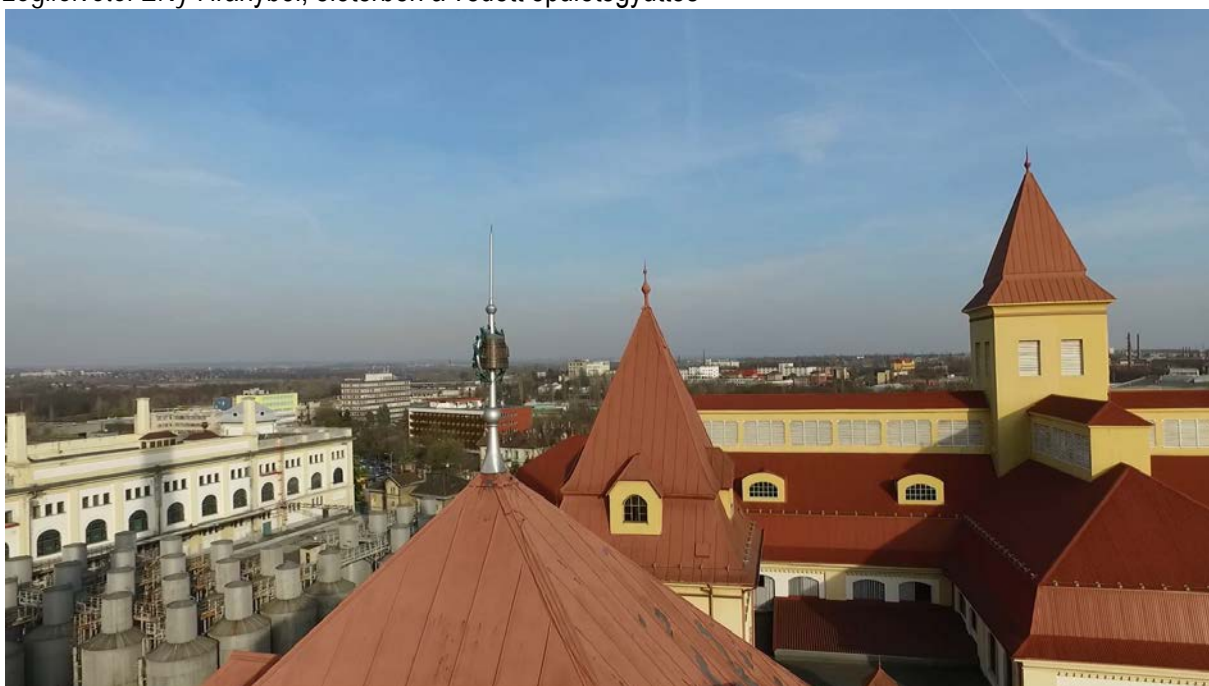
A védett épületegyüttes tornyai ( a felújított toronydísz, a kép előtérben a felújításra váró tető hámlott fémlemezfedése)
