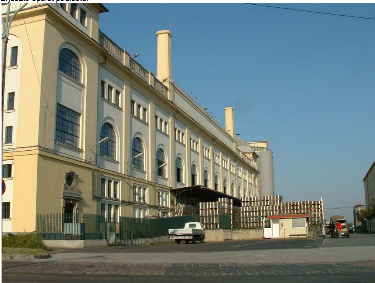
Hordófejtő épület felújított homlokzata (korábbi kép 1997. év)
