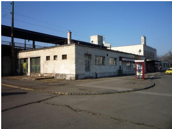
Kőbánya alsó vasútállomás – állomásépület
