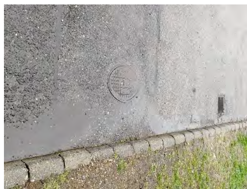
Föld alatti tűzcsap a Halom utcában
