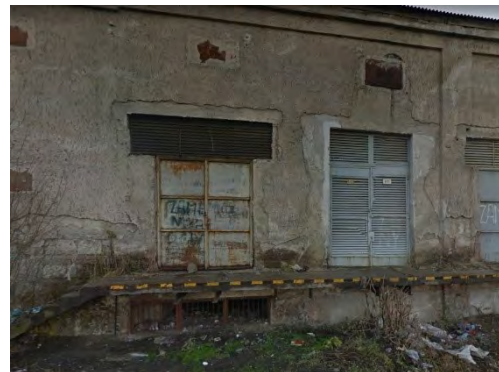
29111/10 épületben elhelyezett 10/0,4 kV-os transzformátor, Előd köz
