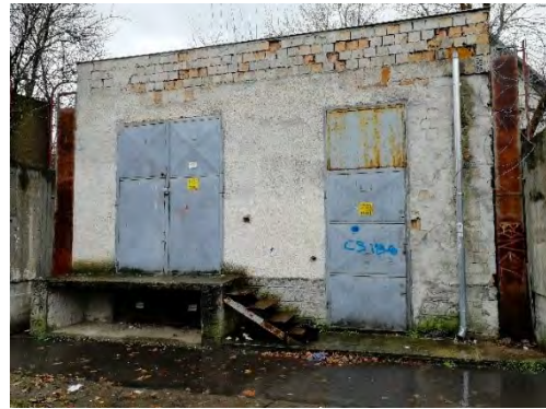
28131/10 építettházias transzformátor 10/0,4 kV-os transzformátor, Bánya utca
