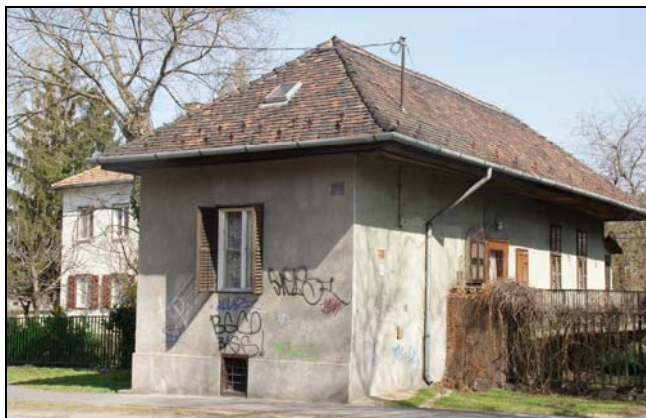
Az utcavonalból kilépő épülettömeg
