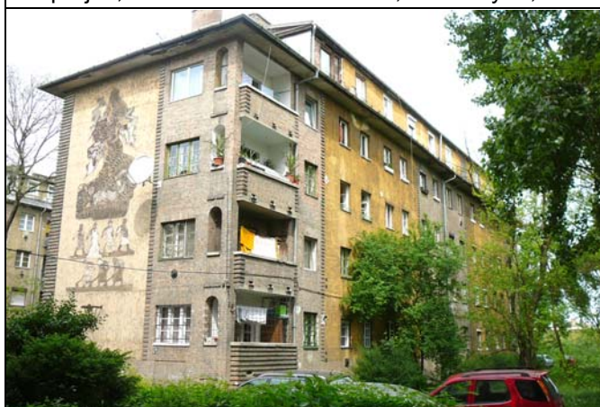
A 3-emelet magas sgraffitto, a loggiasor és a kiugratott sorokkal szegélyezett téglalburkolat igen dekoratív
