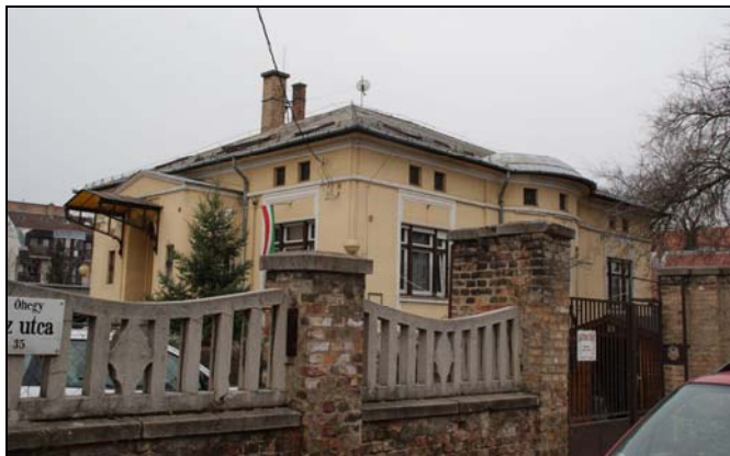
Udvar felőli homlokzat
