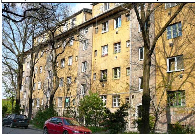
A bejárati oldalon a lépcsőházak kissé kiugratott lizénái és a „szárnyasajtók” gazdagítják az architektúrát
