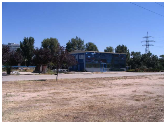
A telephely többszintes konténerépülete
