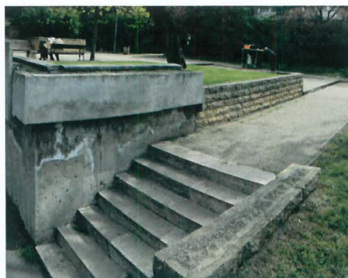
MEGLÉVŐ MŰTÁRGYAK ÚJRABURKOLÁSA
