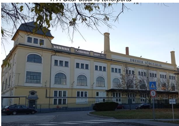
3. A központi épületegyüttes északkeleti homlokzata
