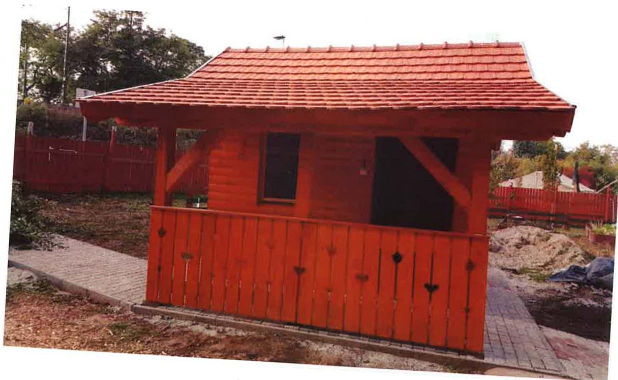
A jegyértékesítő épület
