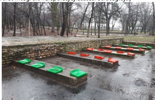
Degradálódott közterület a Csajkovszkij parkban
