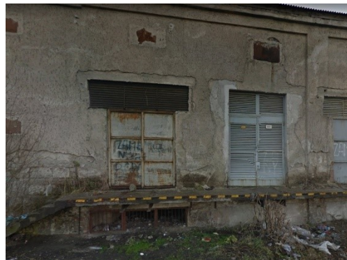
29111/10 épületben elhelyezett 10/0,4 kV-os transzformátor, Előd köz
