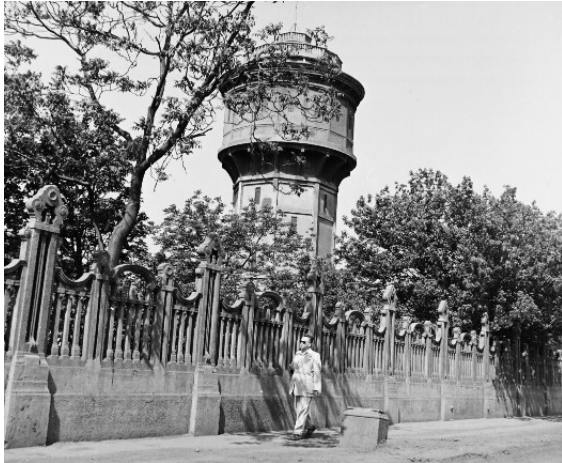
A Kőbányai Víztározó víztornya 1958-ban (forrás: www.fortepan.hu )
