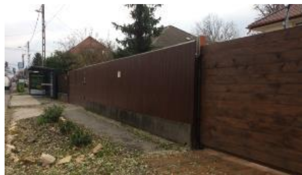
Az VGI.11. módosítással érintett terület kerítése (Forrás: saját készítésű fotók, 2022. október)
