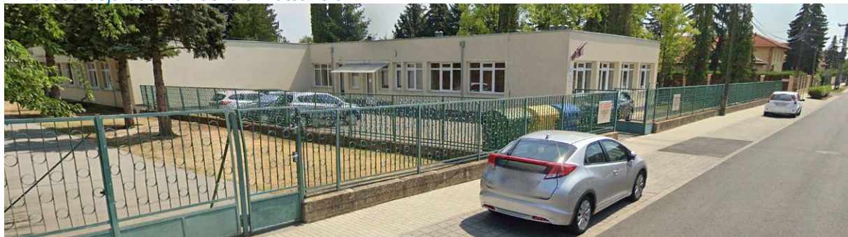
Az óvoda bejárat a Farkashalom utca felől
