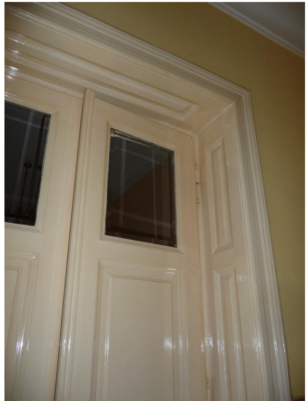
58. b1 jelű ajtó tokborítása és metszett üvegezése
