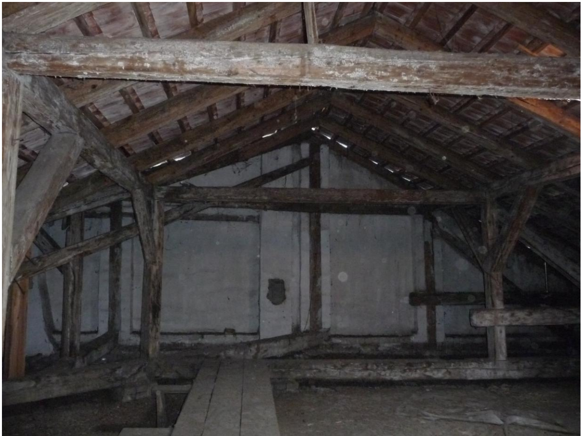
10. Eredeti (1873-1878 közötti) fedélszerkezet az utcai oldalon
