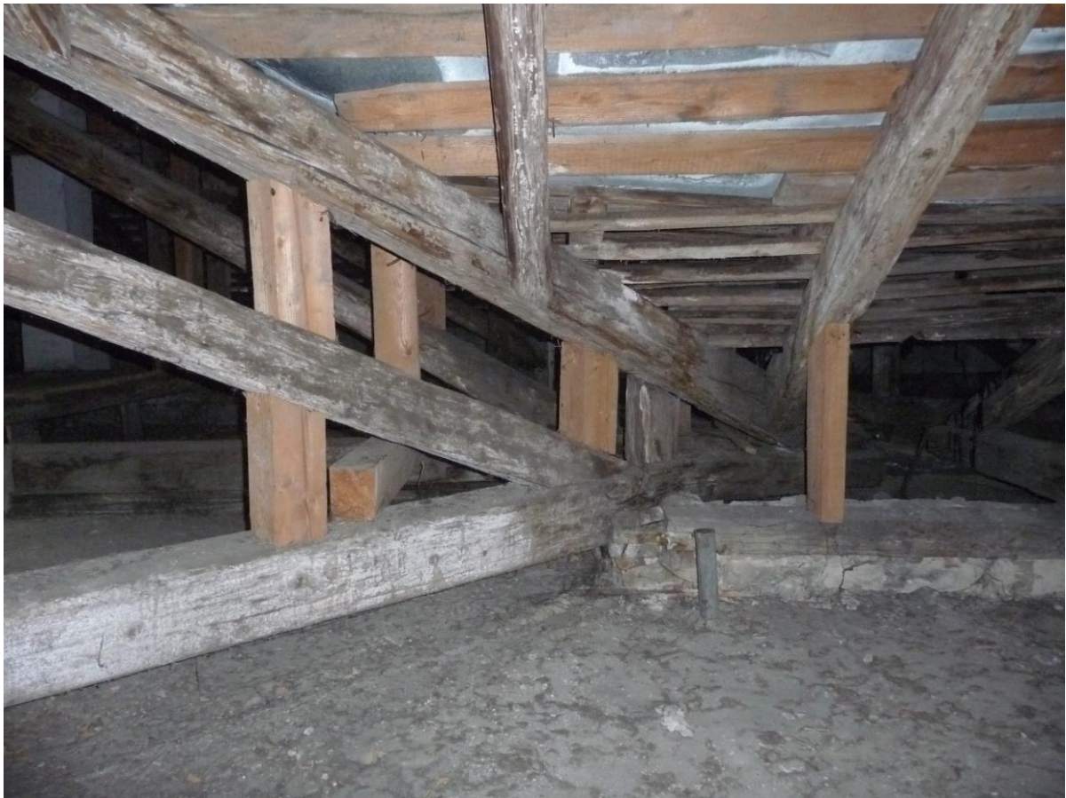
12. A vápacsatorna alatti megerősítés
