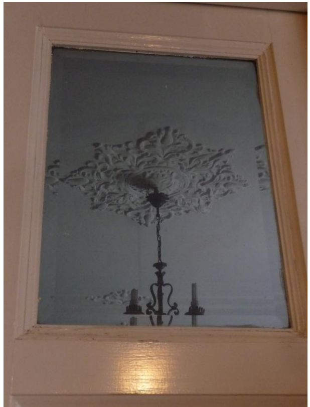
67. Gipsz rozetta és gipsz díszítés a 2/5 helyiség mennyezetén
