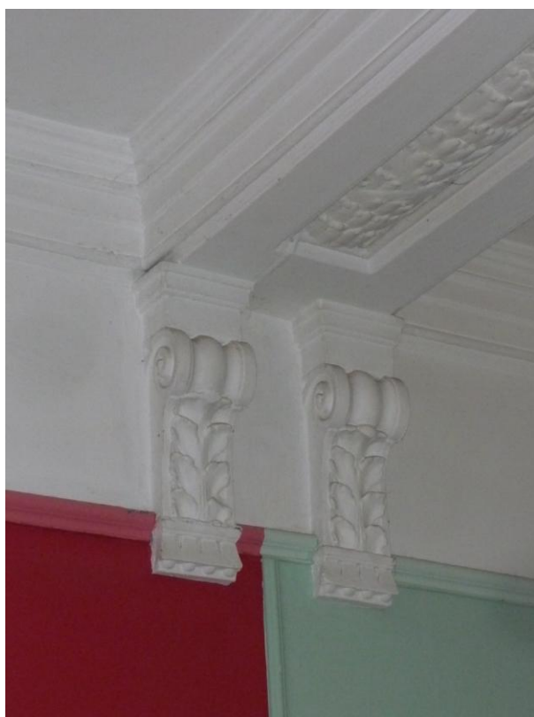
62. Kettős konzol és mennyezet alatti párkány
