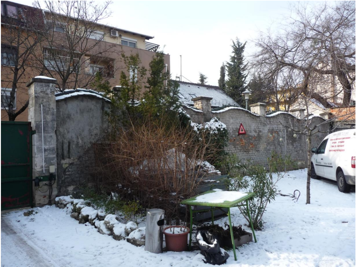
102. A kerítésfal belső nézete
