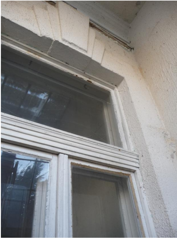
77. A6 jelű ablak külső nézete a zárókövel
