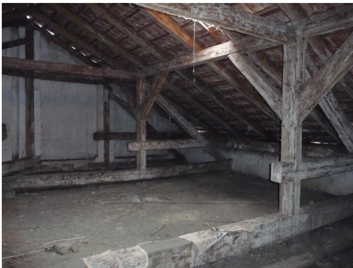
9. Eredeti (1873-1878 közötti) fedélszerkezet az utcai oldalon
