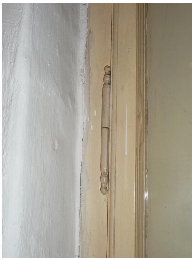
83. Hosszított diópánt az A7 jelű ablakon
