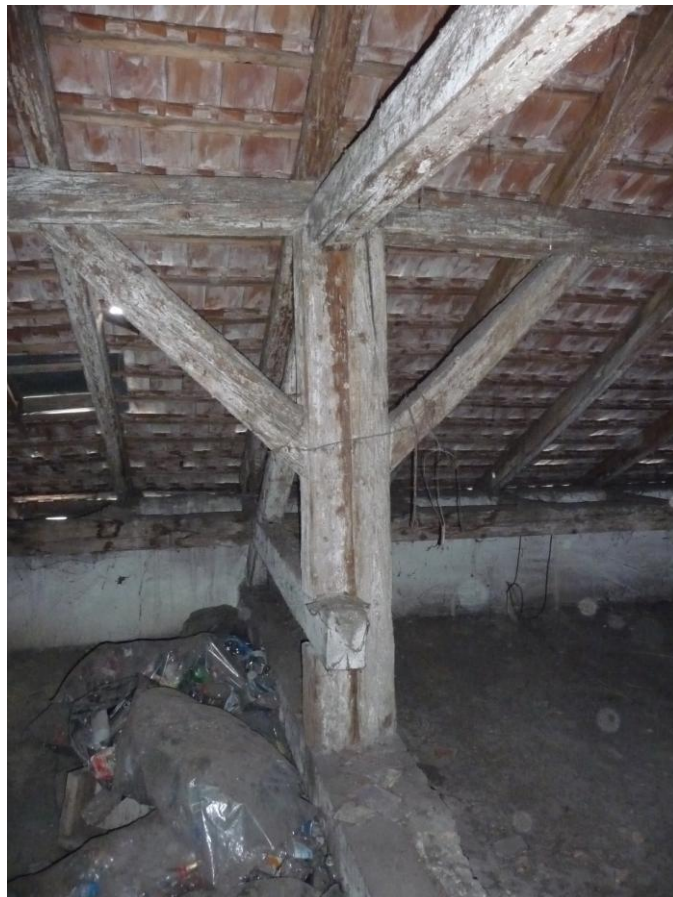
11. Fedélszerkezet bővítése 1903-ban, megkettőzött főállással
