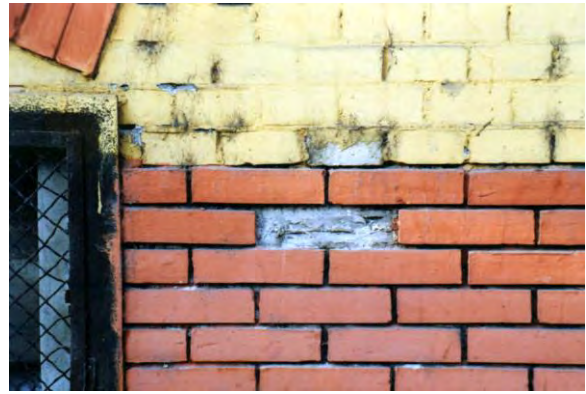
A fal és a lábazat minőségi és méretbeli különbsége
