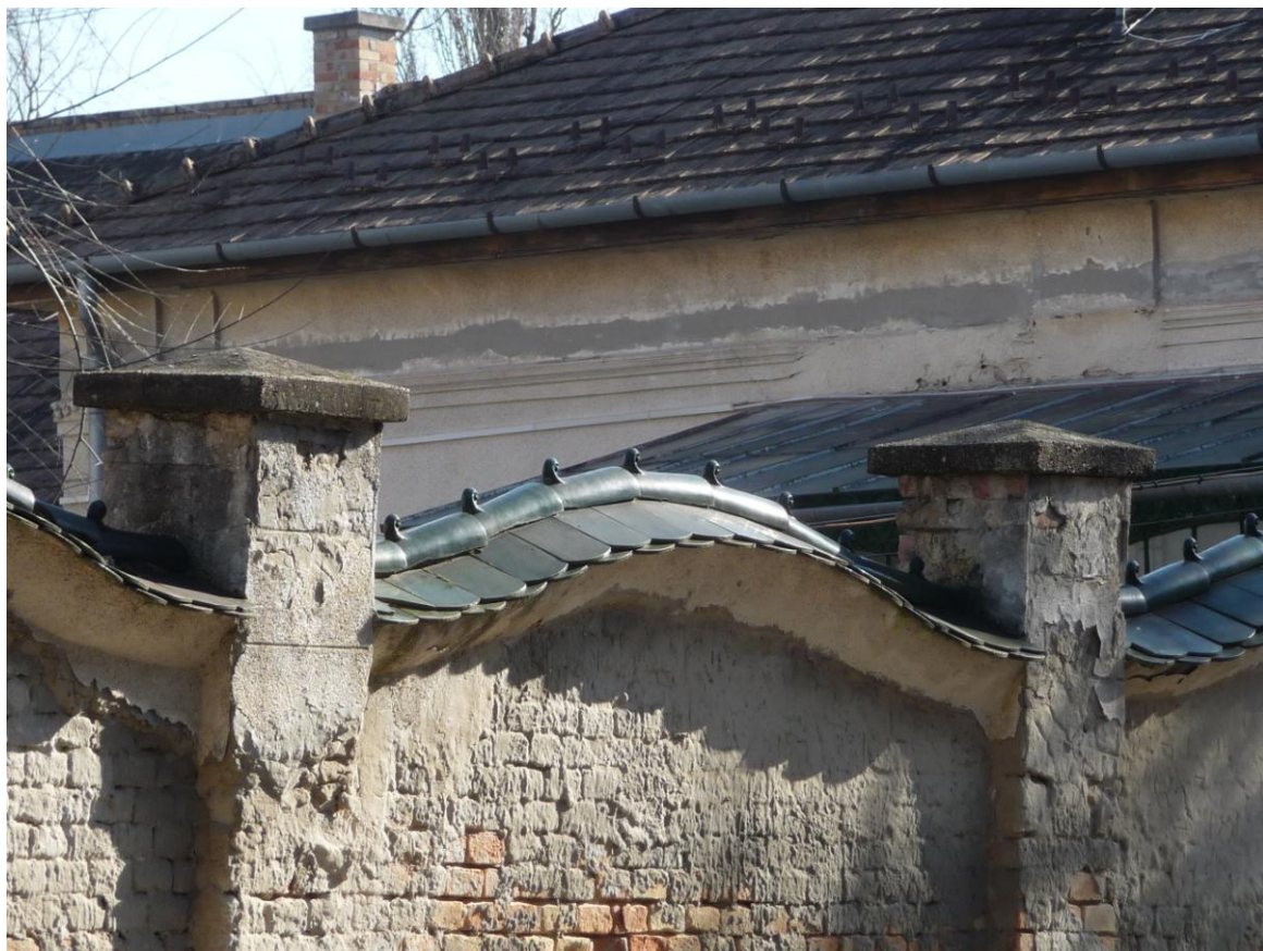
98. A kerítésmezők hullámzó lezárása, fedés Zsolnay cseréppel
