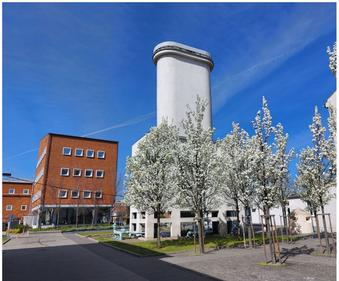
Törzsgyári hűtőtorony és géppuska bunker
