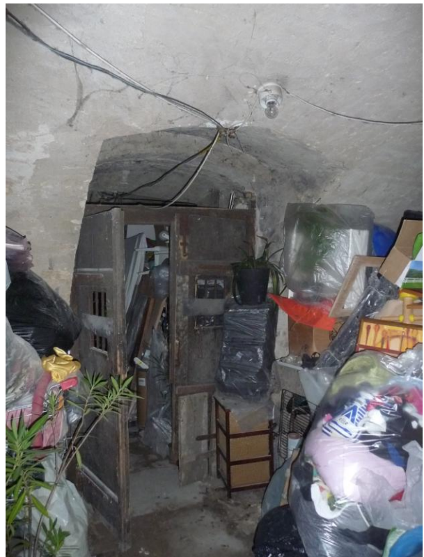
91. Belső pincaajtó, felette fiókboltozattal
