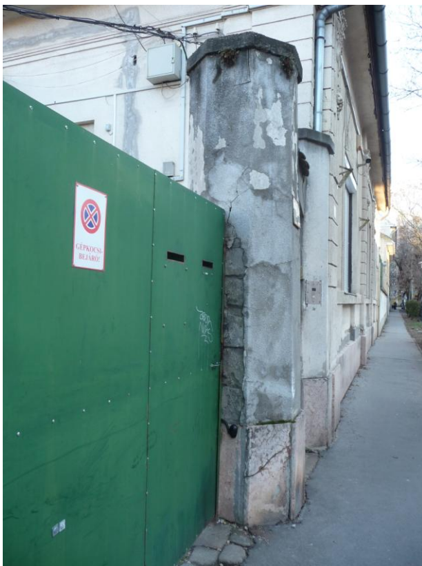
99. Az 1882-es kerítésből megtartott -akkor jobb oldali- nyolcszögű kapupillér
