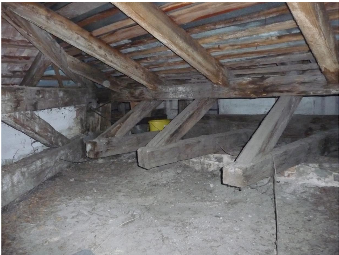
13. Az udvari szárny eredeti (1873-1878 közötti) fedélszerkezetéhez csatlakozó 1903-as bővítés
