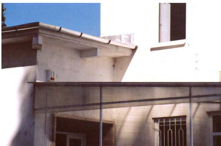
Az irodaszárny csatlakozása és egy újabb előtető
