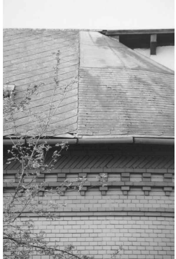
Az épület falának utólagos „meghajlítása”, s ennek hatása a tetőfedésre
