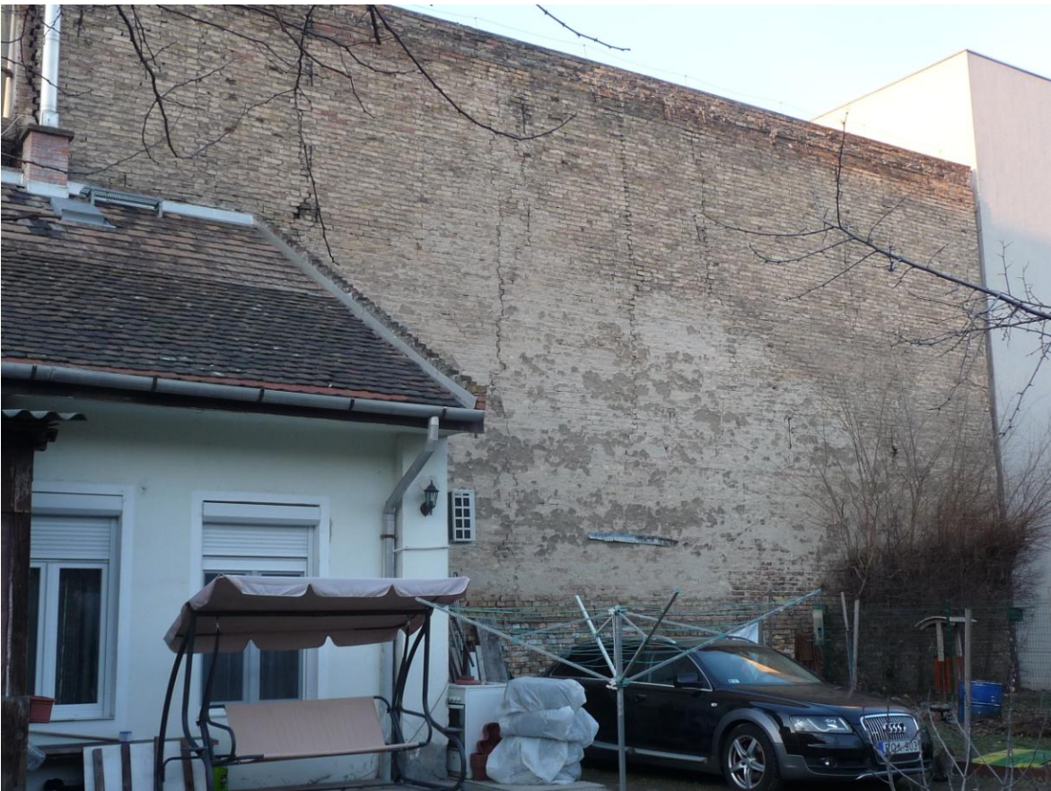
93. A melléképület lebontott részének lenyomata a szomszéd épület tűzfalán
