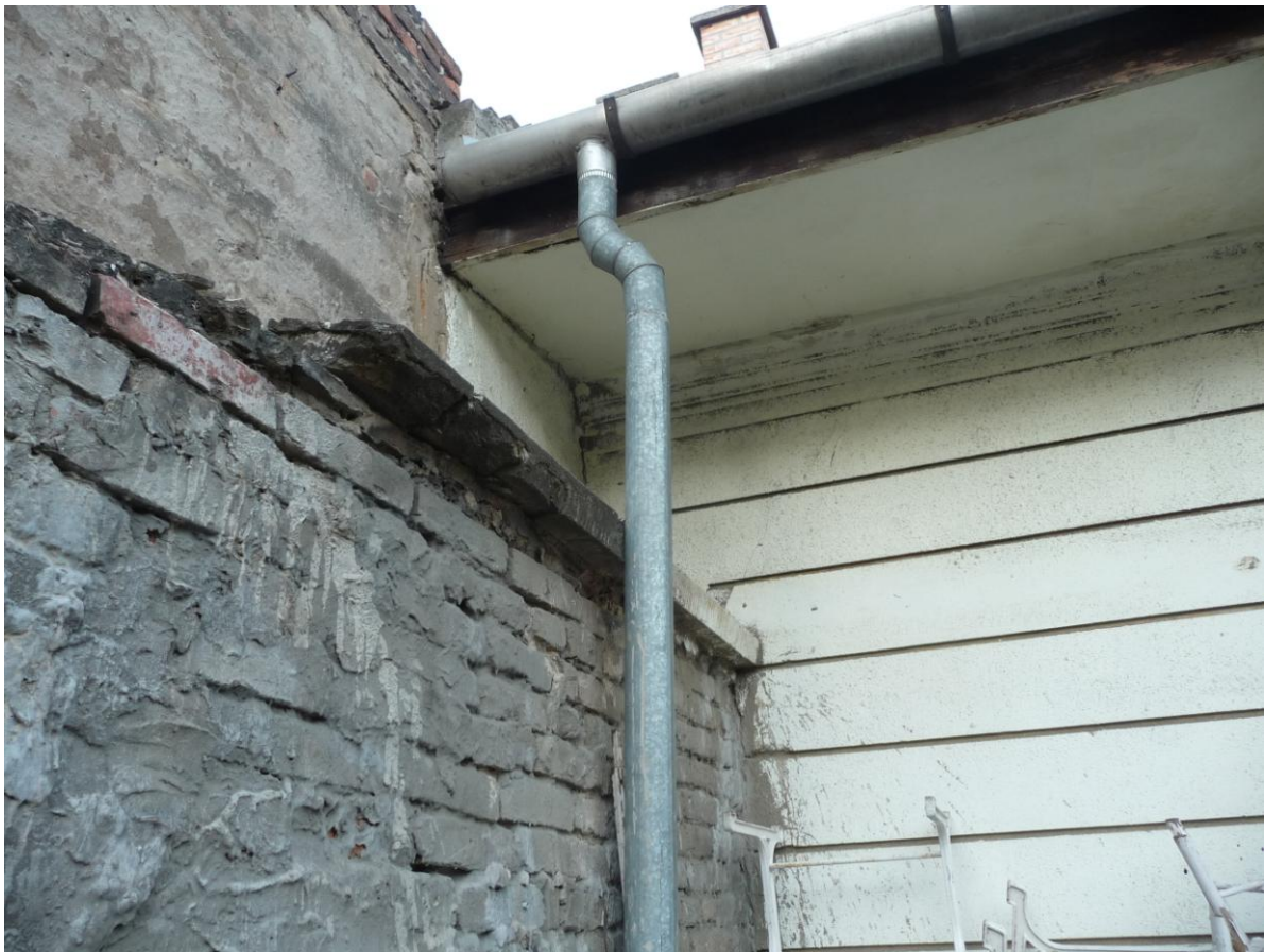
96. A melléképülethez csatlakozó falazott kerítésfal-szakasz az egyenes lezárással
