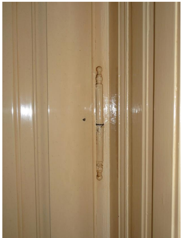
60. hosszított diópánt b1 jelű ajtón
