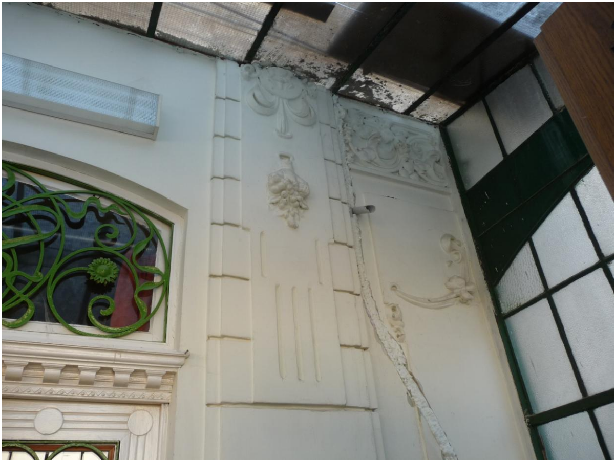
26. Az üvegtetővel kettévágott főbejárat melletti lizéna és további gipsz díszítések a lizéna és a veranda végfala között
