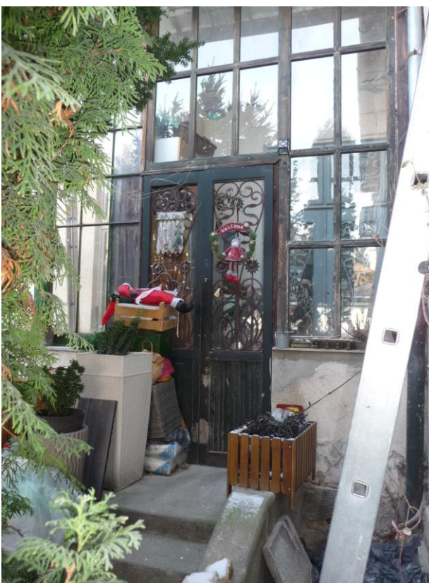
53. Télikert átalakított szakasza a 2. sz. lakás új ajtajával
