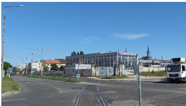
Felújított csarnoképület, Vaspálya utca 23-25.
