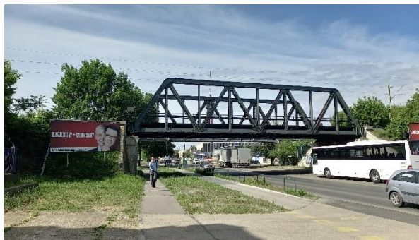
Kőér utcai vasúti híd
