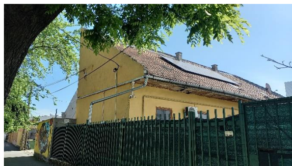
6. Kőér utca (lakóépület, hrsz.: 41569)
