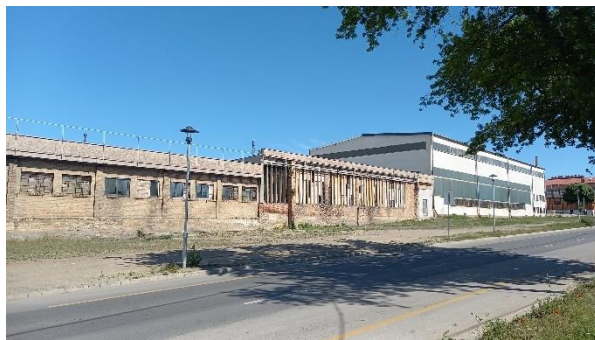
Kőér utca menti rossz állapotú csarnoképületek
