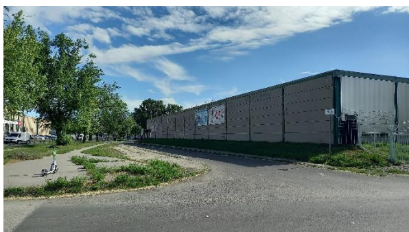
Budapesti Közlekedési Zártkörűen Működő Részvénytársaság Metró Üzemigazgatóság, M3 járműtelep főépülete
