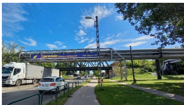
Kőér utcai távhővezeték és vasúti híd
