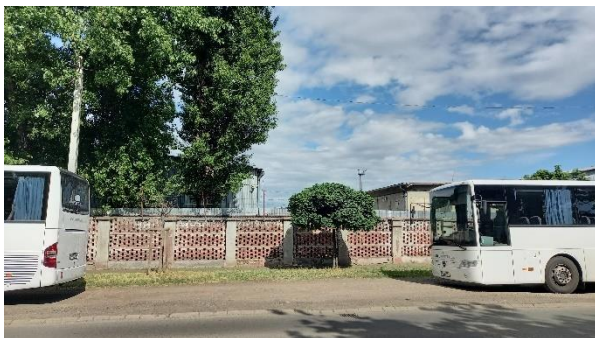
11. Kőér utca 3/e (baloldali csarnoképület, hrsz.: 38303/66)
