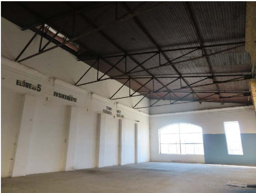
22 Közgépház és kazánház belső részlet
