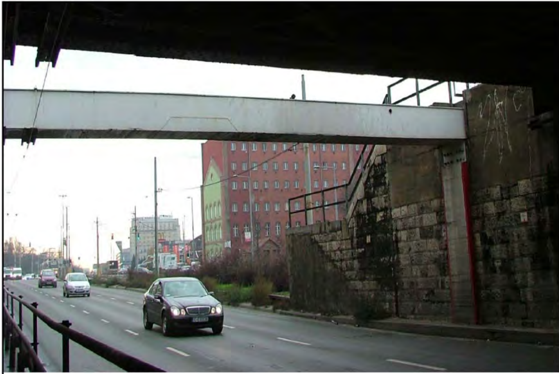
Magasságjelző és baloldali szárnyfal kapcsolata
