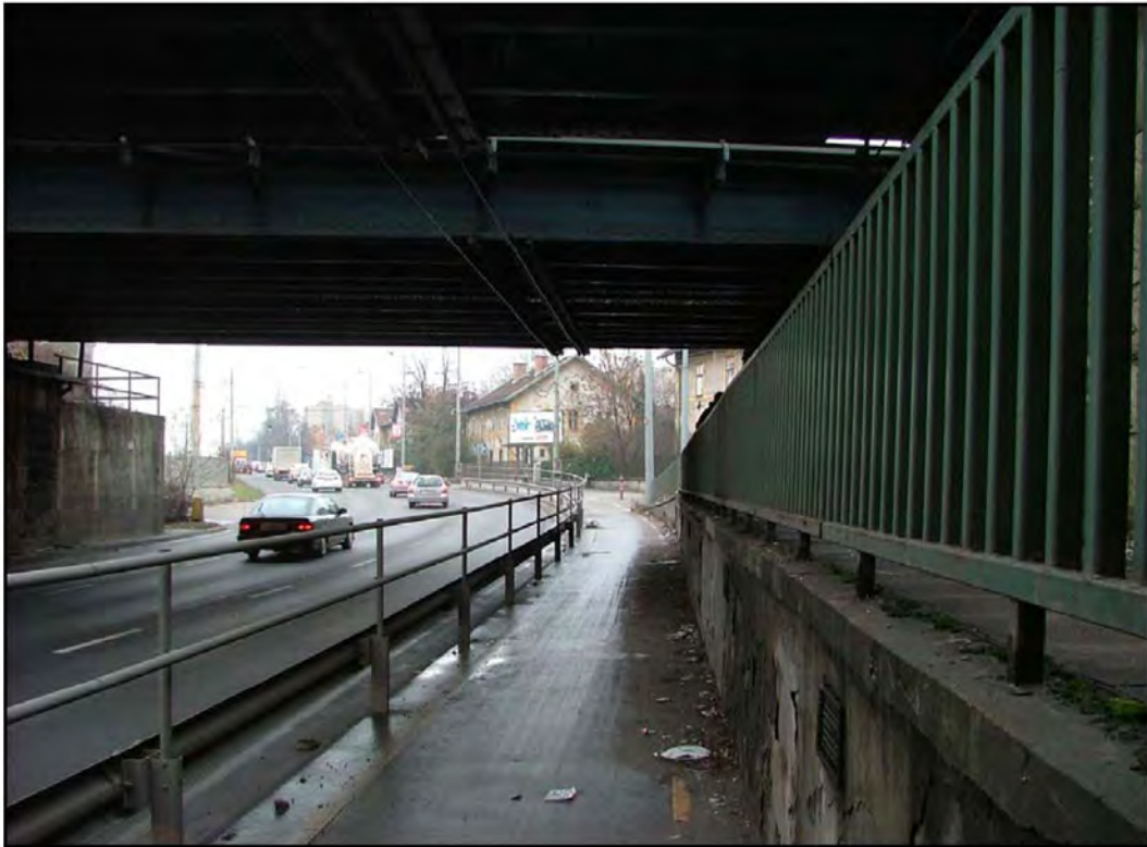
Kerékpárút, járda kialakítása
