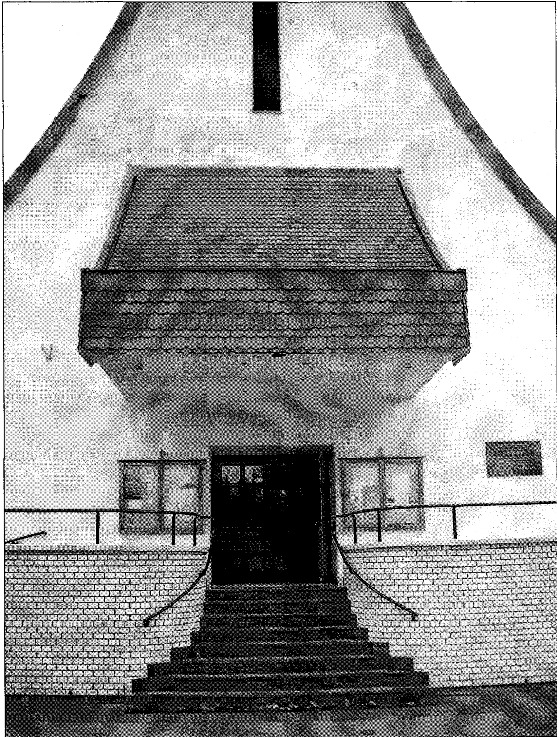
Kőbányai Szent György plébániatemplom bejárata Megfigyelhető a függőleges cserépsorok elmozdulása
