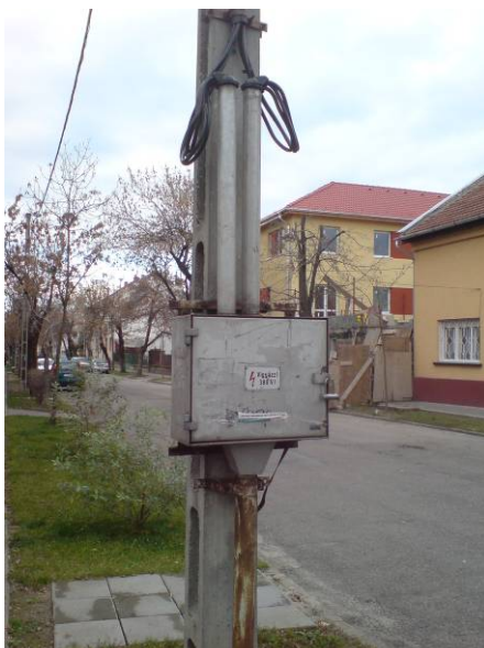
Petrőczy utca és az Alkér utca kereszteződéséhez közel lévő oszlopon elhelyezett kífeszültségű elosztó (földkábel betáplálás, légvezetékes elmenő)
