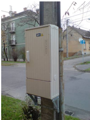
Oszlopon elhelyezett közvilágítási kapcsolószekrény a Gergely u. és a Diósgyőri u. sarkán
