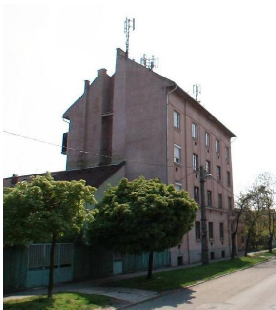
Kőér u. 34. tetőszerkezetén lévő antenna
