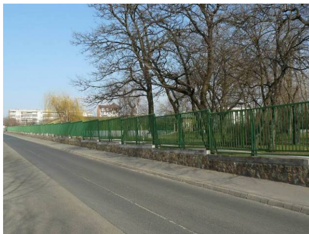
lhász utcai vízműtelep
