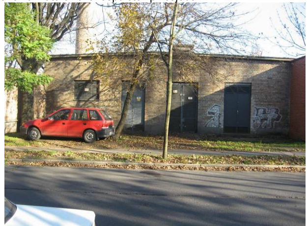
A 1391-es számú 10 kV-os kapcsolóállomás és a 1391/2-es számú transzformátor önálló épületben
