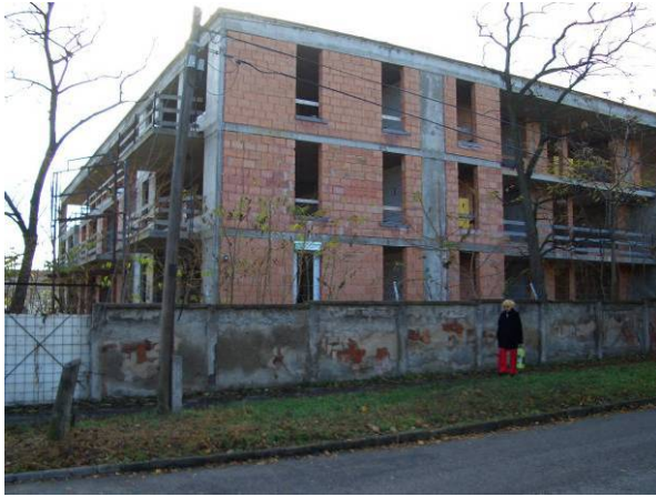
77. Félbehagyott társasház-építkezés L4 keretövezetben
