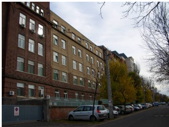
86. Az 1932-ben átadott régi épületszárny a Sörgyár u. felől
