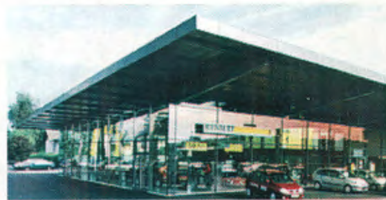
Element-Dach auf Binder
