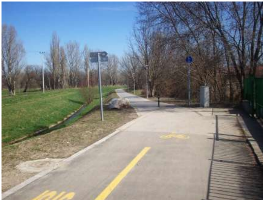
2.5. ábra Az októberben elkészült Cinkotai út – Rákoscsaba utca szakasz, a Rákoscsaba utca felé
