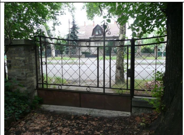
A kovácsoltvas kerítés váza megmaradt, a dróthálós betét helyén azonban betonvas háló készült, de a kerítés karktere megmaradt.
