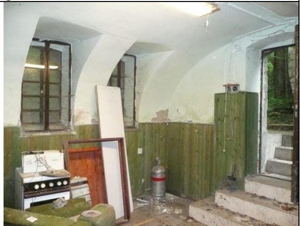
A boltíves pince szerkezeti jó állapotú, de mindenhol vizesedik, a vakolat málik.
