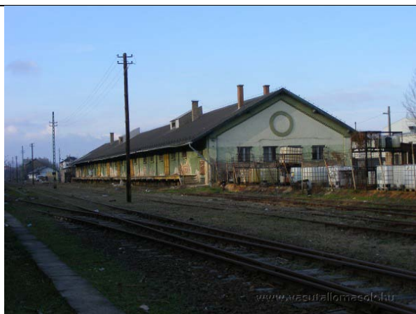
A raktárépület a vasút irányából
