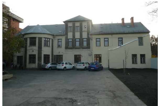
Az épület hátsó homlokzata
