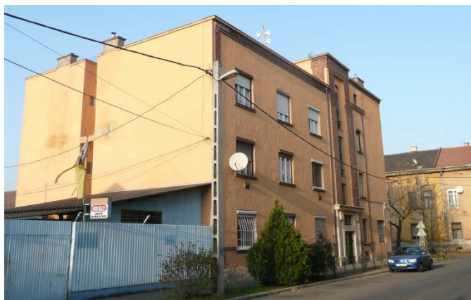
Az épület délkeleti tűzfala
