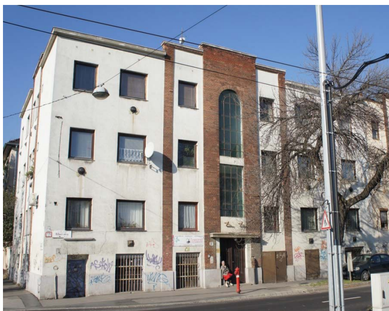
Az épület utcahomlokzata
