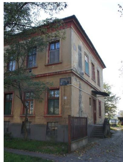
Az épület északkeleti sarka
