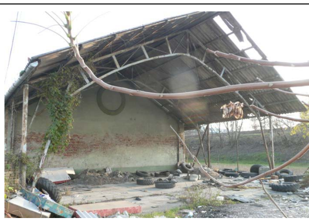
A raktár északi oldalán álló acél-tetőszerkezet
