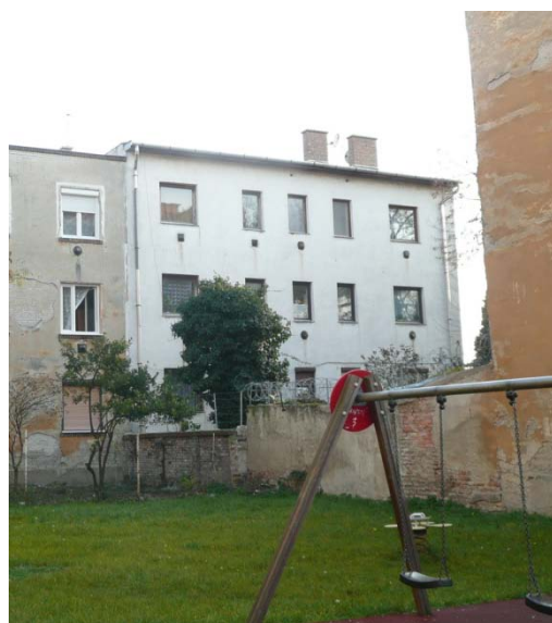
Az épület udvar felőli, hátsó homlokzata
