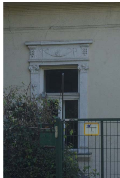
Ablak az utcahomlokzaton
