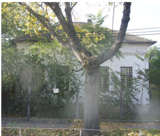
Az épület utcahomlokzata
