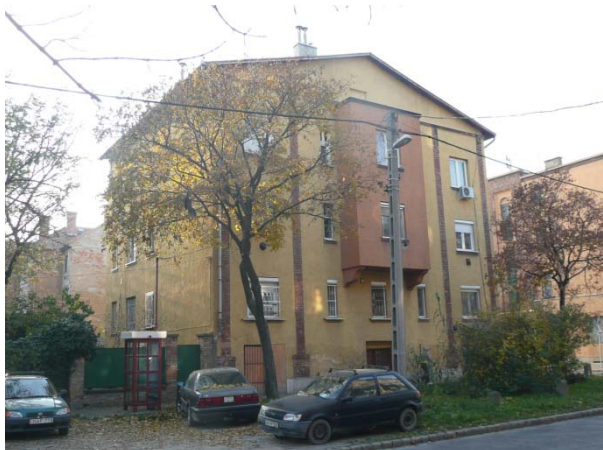
Az épület Szállás utcai homlokzata
