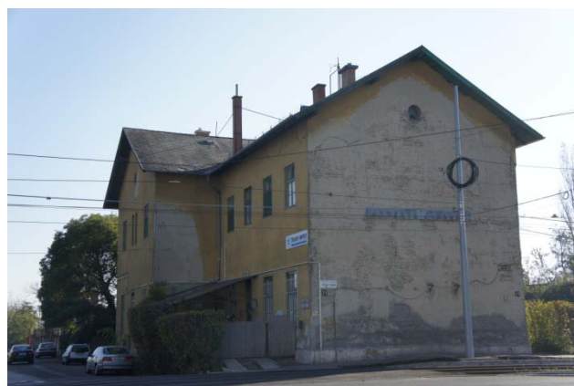
Az állomás Bihari utca felőli homlokzata
