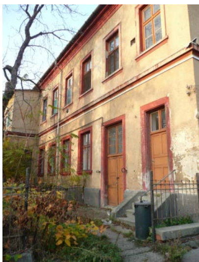
Az épület hátsó homlokzata
