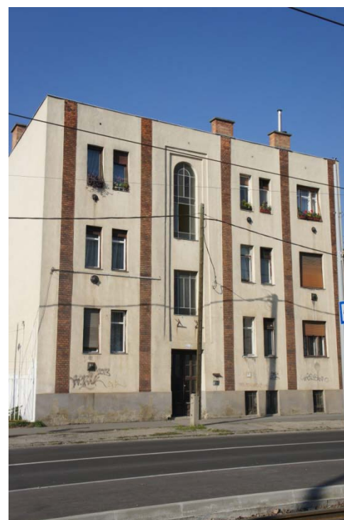
Az épület utcahomlokzata
