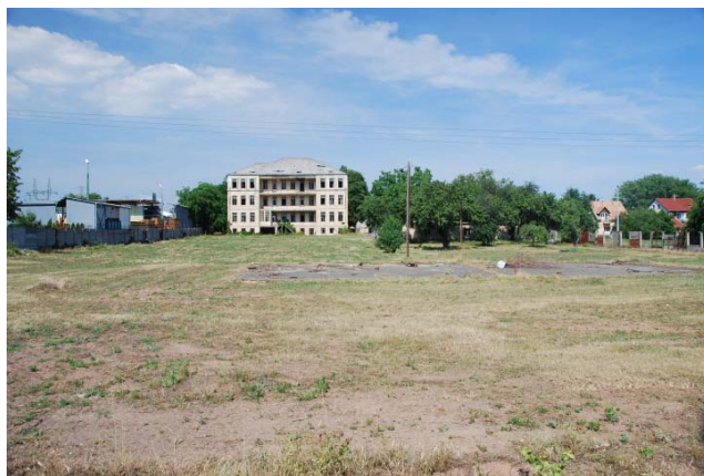
Tehtélyes (köz)épületként a környezetben
