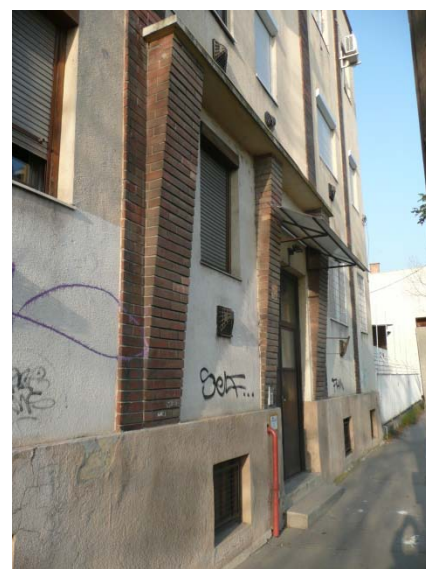
Az épület tégladíszítéses, hangsúlyos főbejárata
