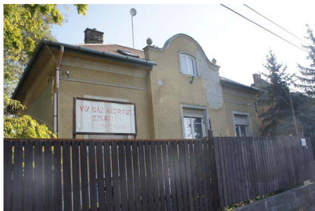
Az épület középső traktusa
