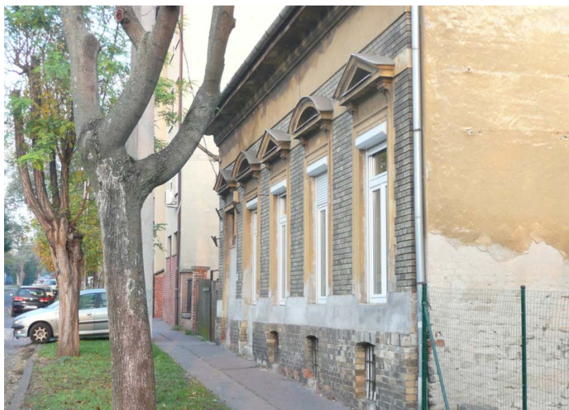
Az épület utcahomlokzata
