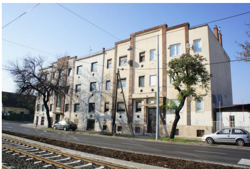
Az épület utcahomlokzata (baloldalán a hozzá nagymértékben hasonló, ugyancsak háromemeletes lakóépület)
