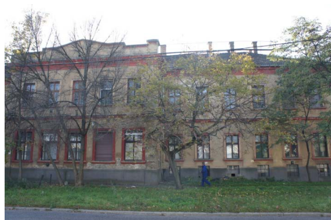
Az épület középső, illetve északi traktusa
