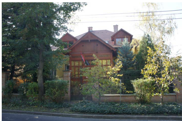
Az épület utcahomlokzata
