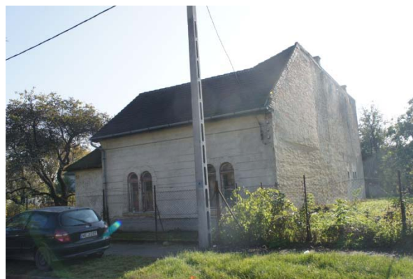
Az épület nyugati homlokzata
