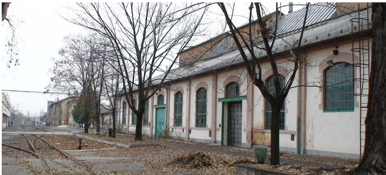
Az „Eiffel-csarnok” mellett álló, 27. számú üzemépület (Fotó: Sánta Péter)
