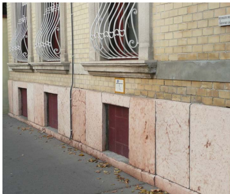
Kőlabazat az utcahomlokzaton
