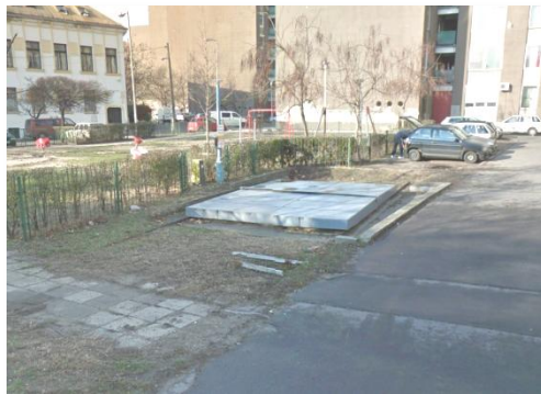
Földbe süllyesztett hálózati gáznyomás-szabályzó a Román utcában
