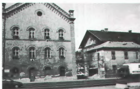
A kőbányai Dohánygyár épülete és bejárata
