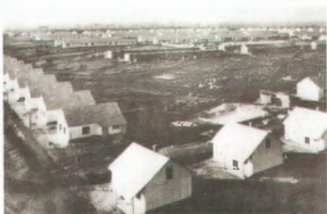
A falu építése közben
