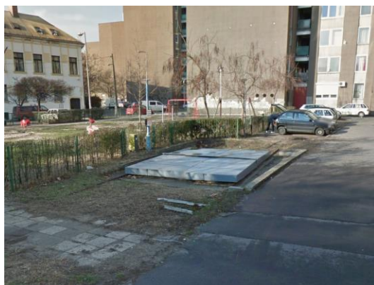
Földbe süllyesztett hálózati gáznyomásszabályzó a Román utcában
