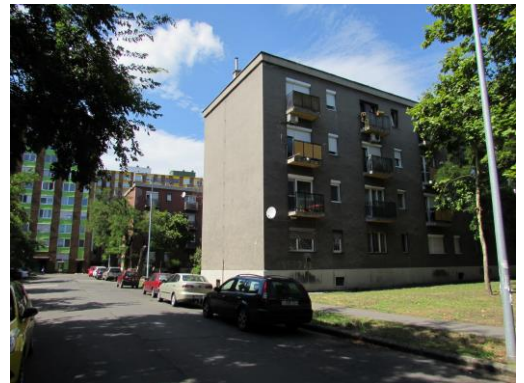
4. Kápolna közben lévő lakóépületek
