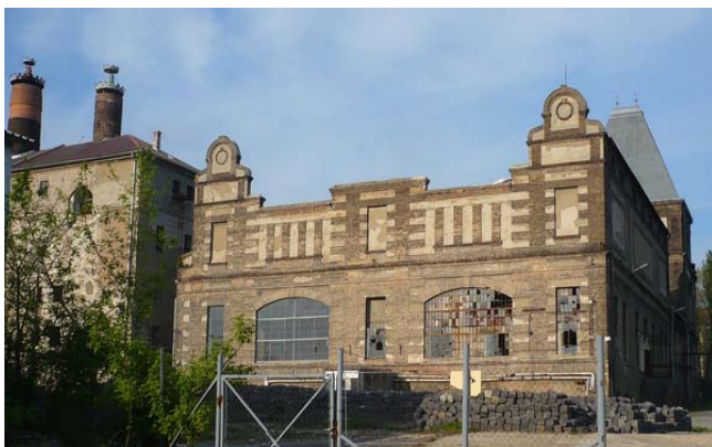
A korabeli erőtelep épülete
