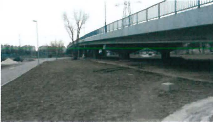
6. Felújított felüljáró a Sibrik Miklós út felől
