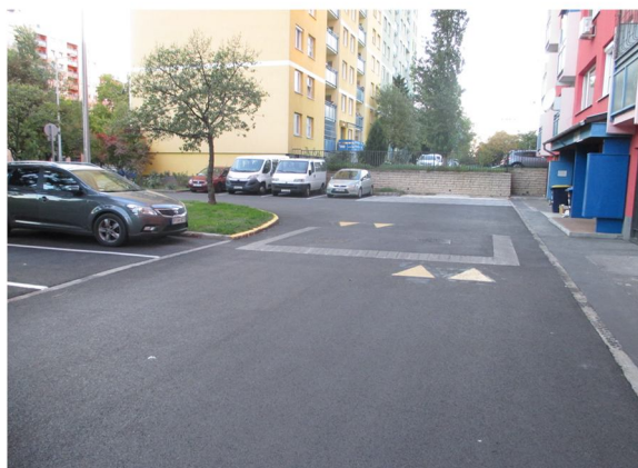
Útfelújítás a Szőlővirág utcában
