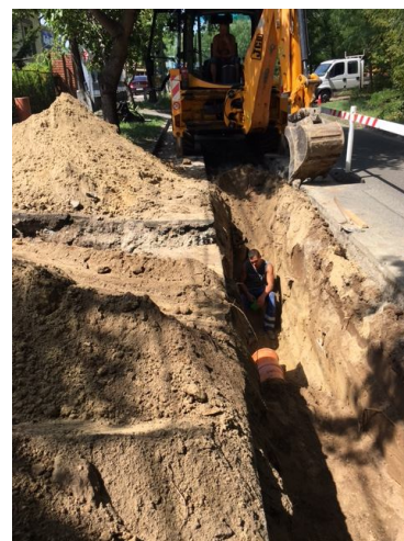
Szennyvízcsatorna-fektetés a Dömsödi utcában
