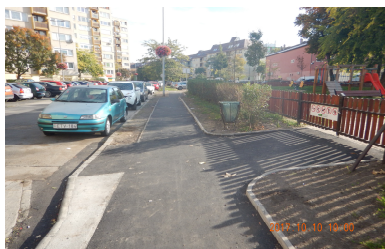
Járdaépítés a Vásárló utcában
