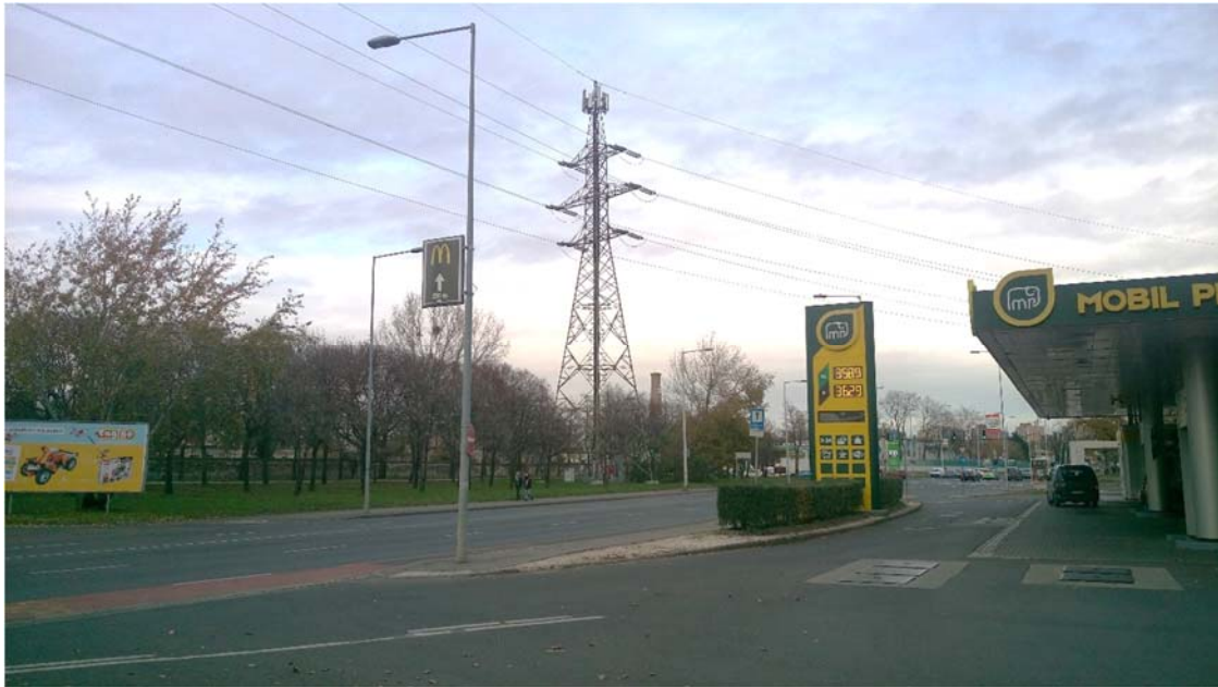
120 kV-os távvezeték és tartószerkezete
