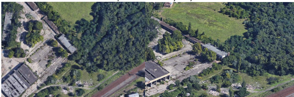
Az elhagyott épület a telek sarkában
