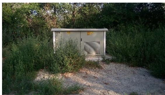
22127 sz. 10/0,4 kV-os transzformátor
