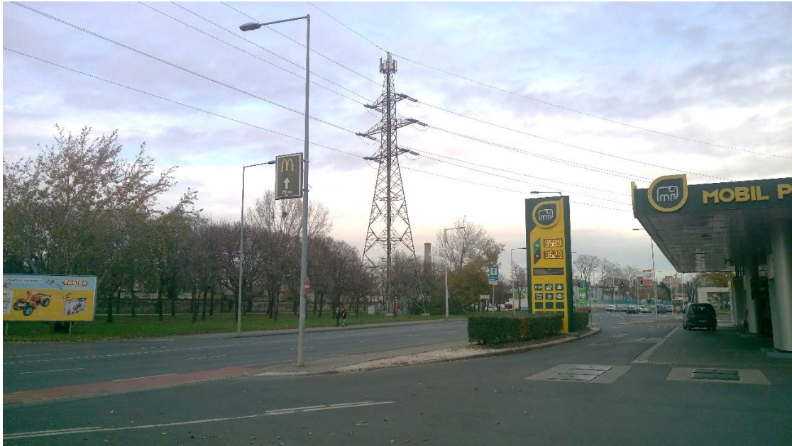
120 kV-os távvezeték és tartószerkezete
