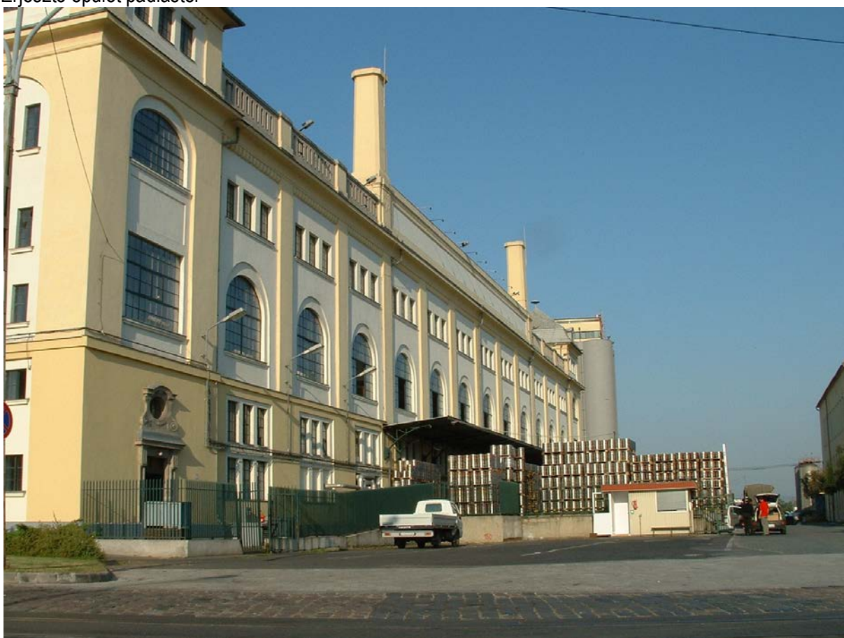
Hordófejtő épület felújított homlokzata (korábbi kép 1997. év)
