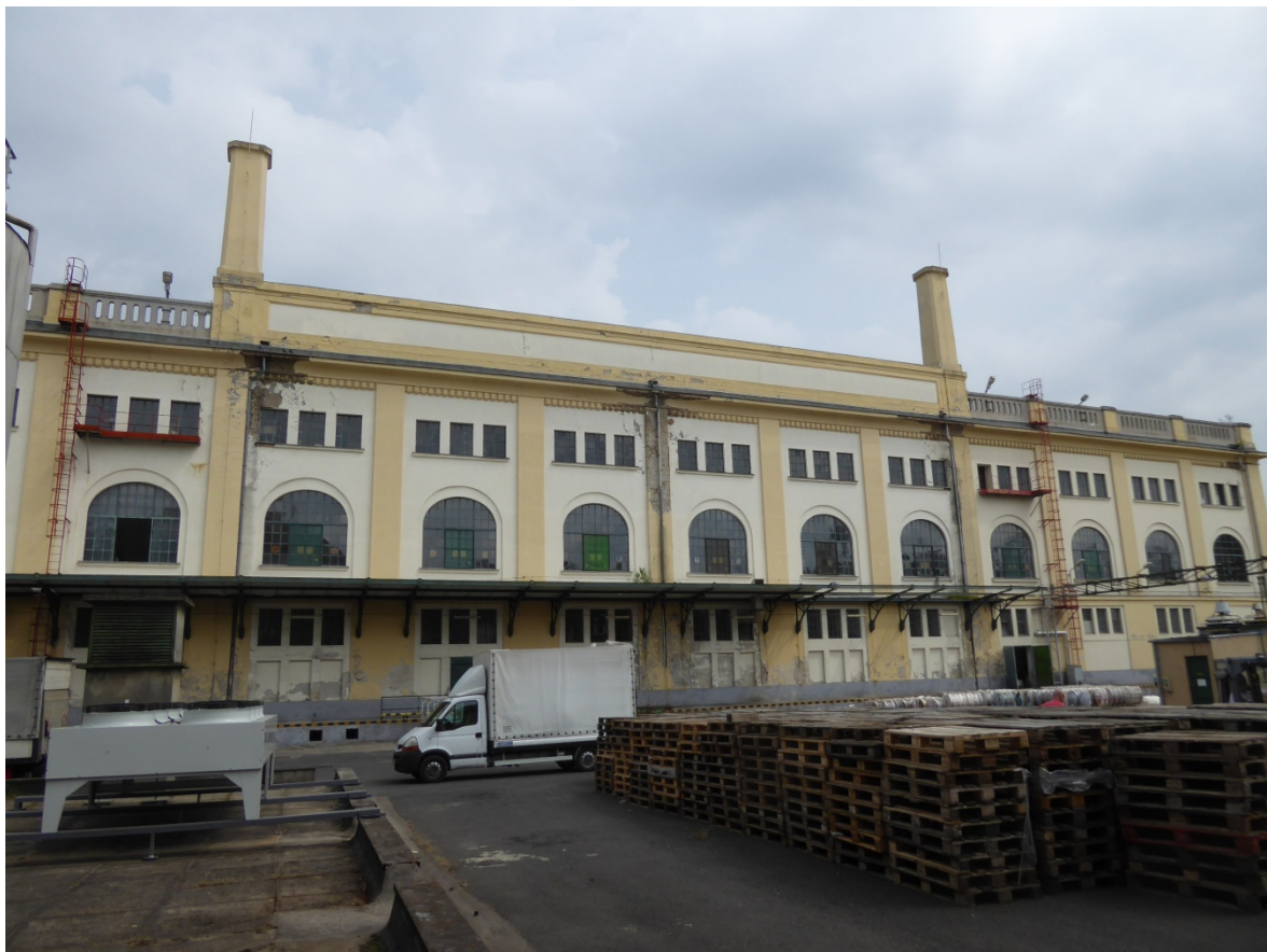
A felújításra váró Hordófejtő épület gyáruzvar felőli homlokzata
