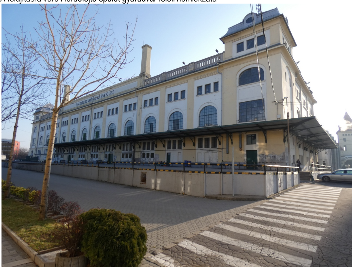
A felújításra váró Hordófejtő épület főhomlokzata
