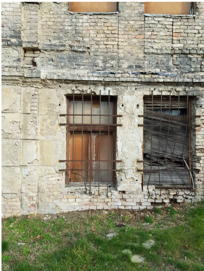
DNy-i homlokzat befalazott ablakok részlet
