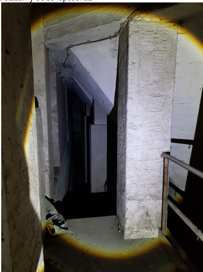
Középső épületszárny betonsiló kúpok a lépcsőházból nyíló közlekedő
