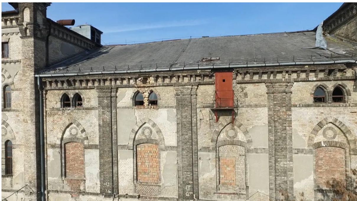
Középső traktus homlokzatrészlet
