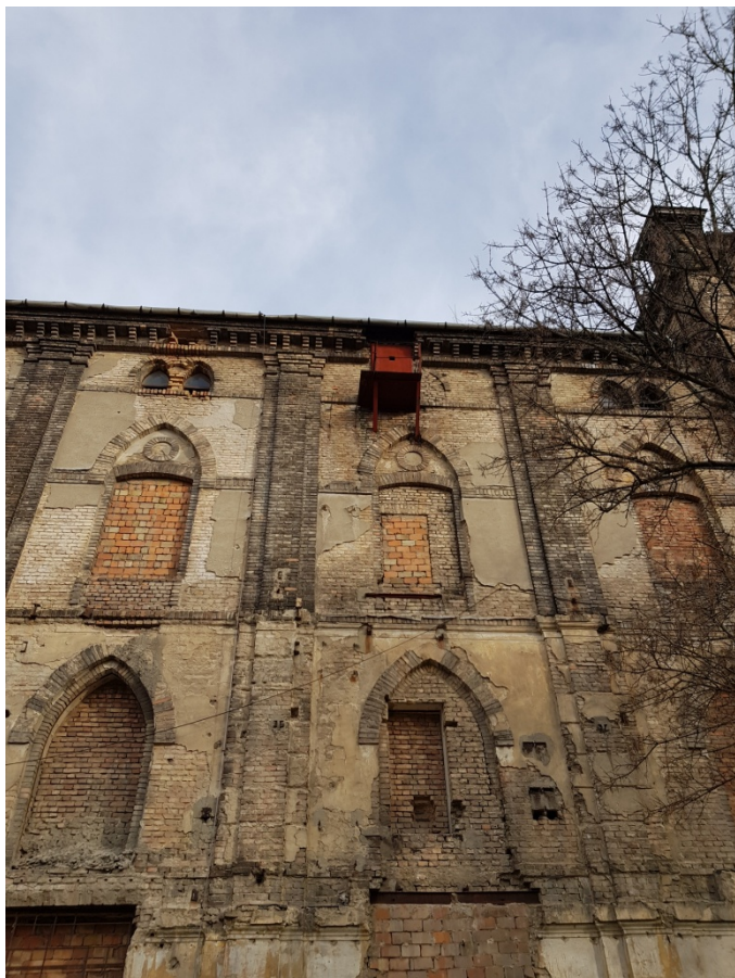
DNy-i homlokzat részlet, a betonsílok miatt befalazott ablakok
