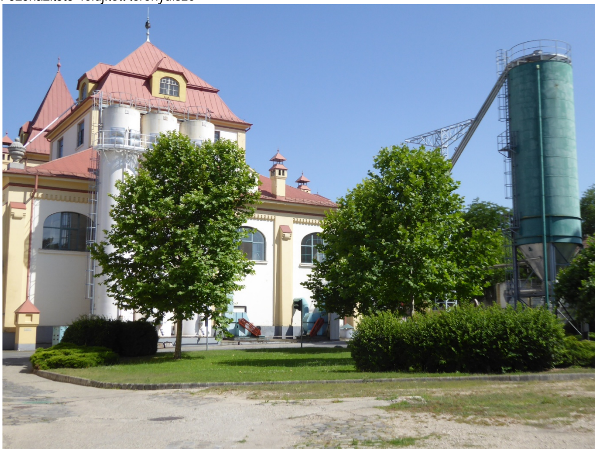
Főzház hátsó homlokzata
