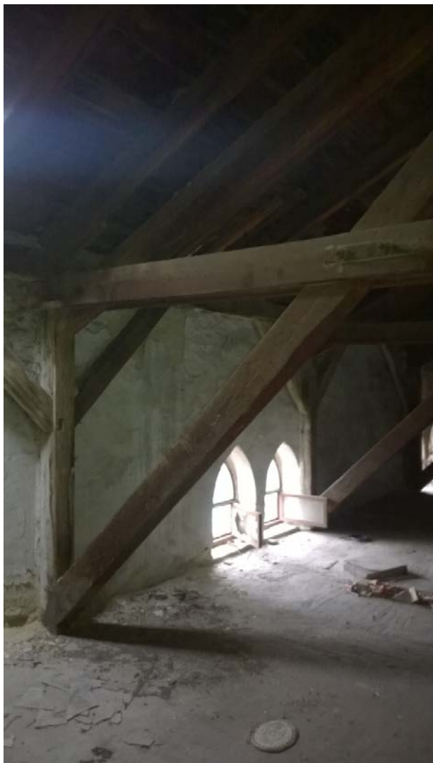
Középső traktus fedélszerkezet
