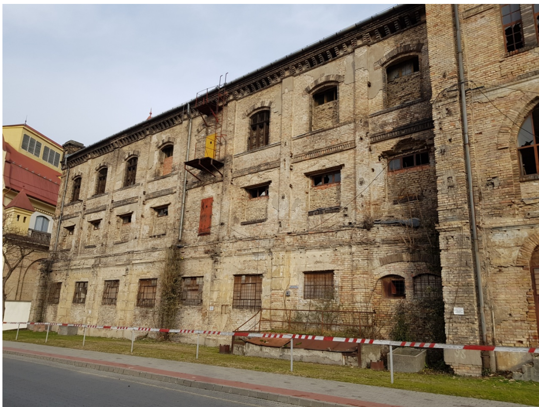
DNy-i homlokzat, padozatos tároló szárny részlet a befalazott ablakkal
