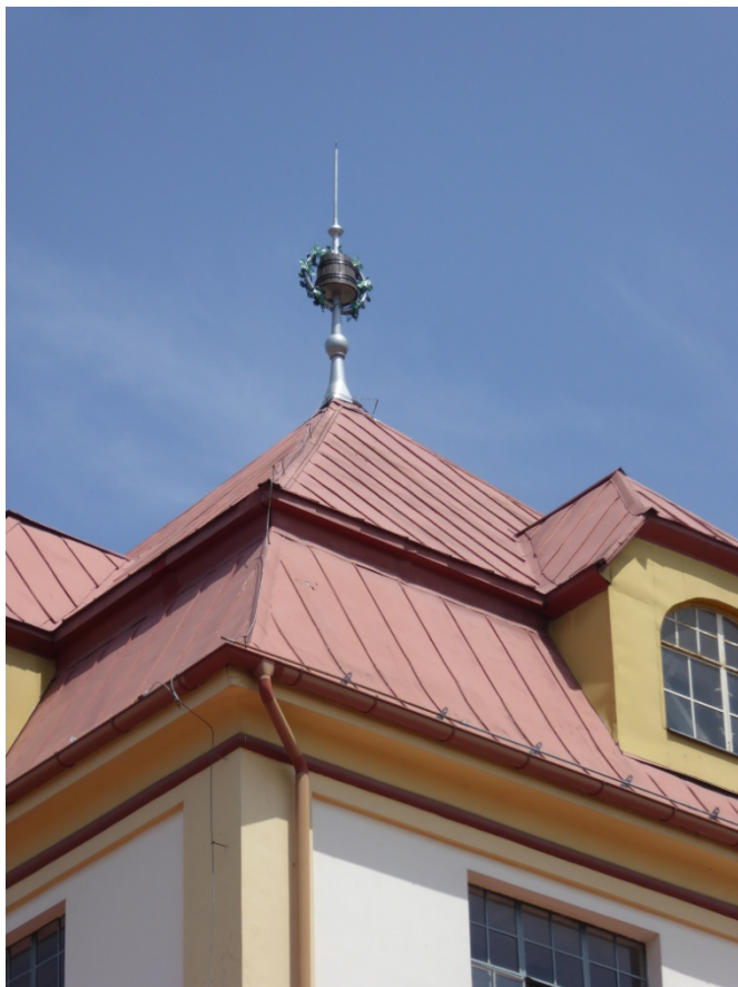
Főzházitető felújított toronydíszje
