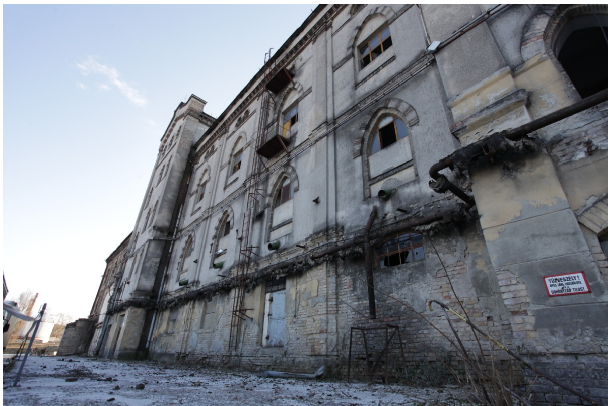
Árparaktár kamionparkoló felőli homlokzata
