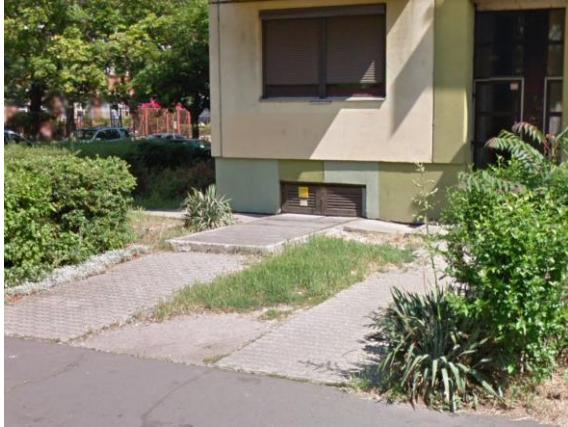
10/0,4 kV-os transzformátor pincszinten elhelyezve
