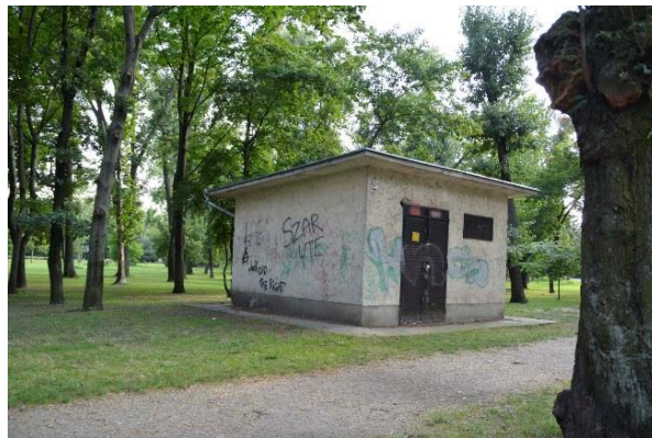
Építettház 10/0,4 kV transzformátor
