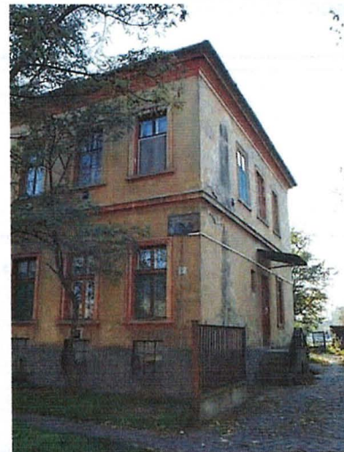
Az épület északkeleti sarka
