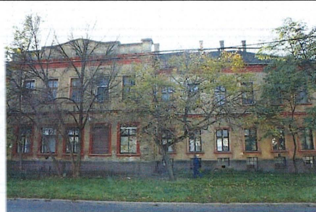
Az épület középső, illetve északi traktusa
