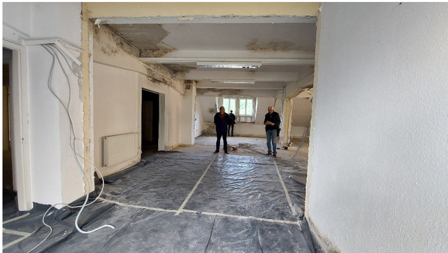
A Csarnoképület melléktere átépítés közben (tervezői fotó).
