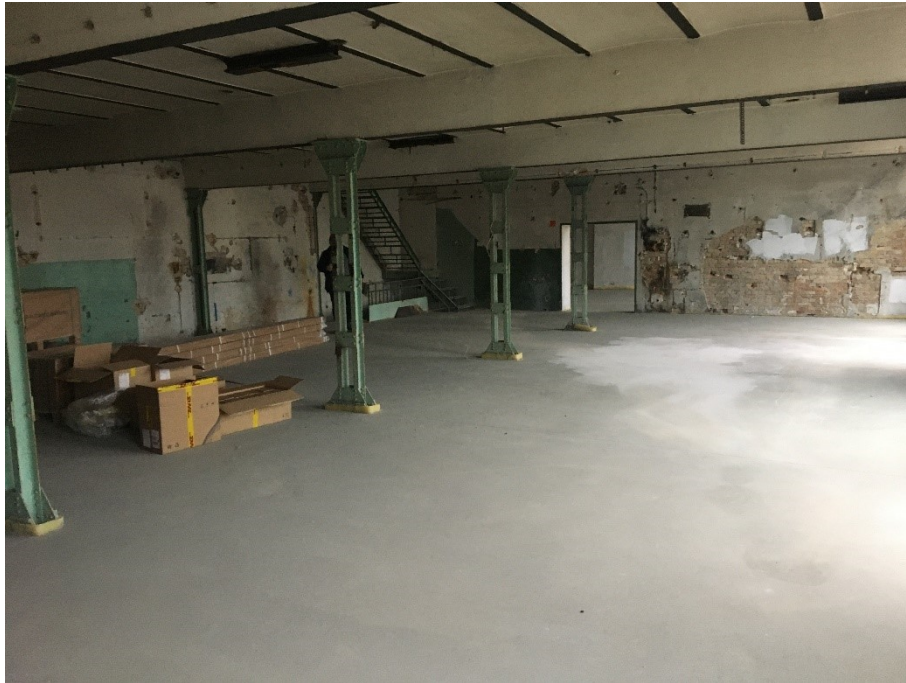
A csarnok melléktere kivitelezés közben (tervezői fotó).
