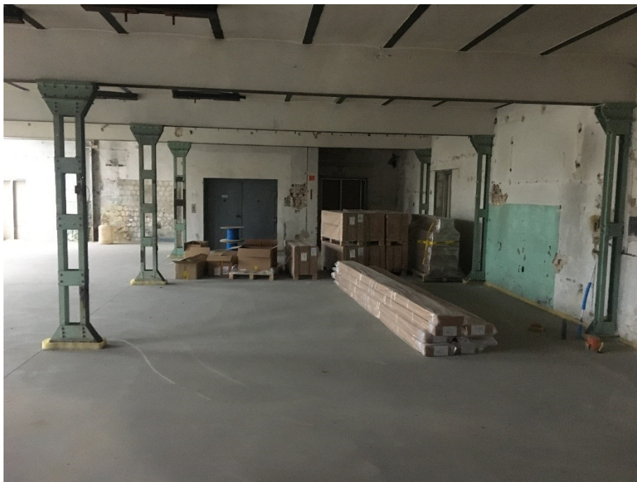
A csarnok melléktere kivitelezés közben (tervezői fotó). Melegenhengerelt vas profilokból szegecselt pillér, hengerelt vas I-gerendás poroszsüveg boltozat.
