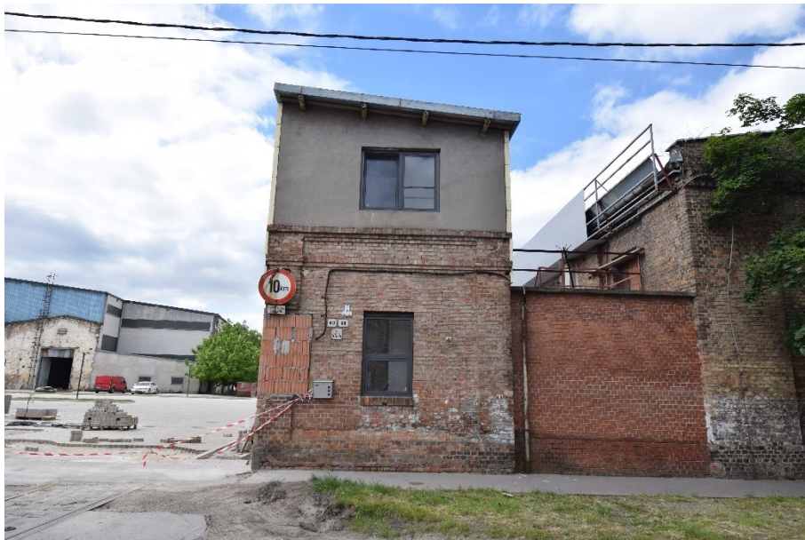
Az épület bejárati oldali, déli sarka.
