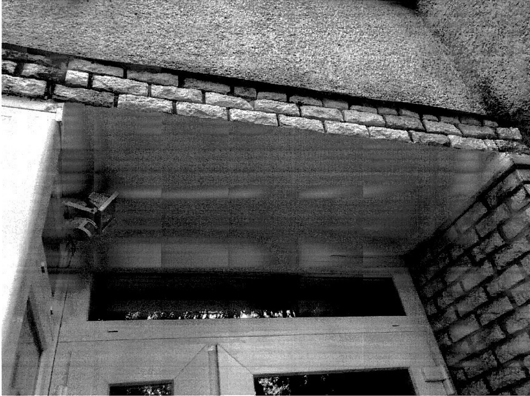
Javítás után. Vakolva, glettelve és fehér kültéri homlokzati festékkal színezve
